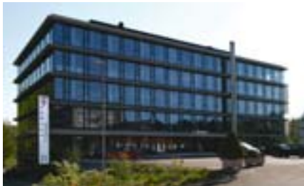
T-Systems-Bürogebäude in Bern, HELVETIA III
